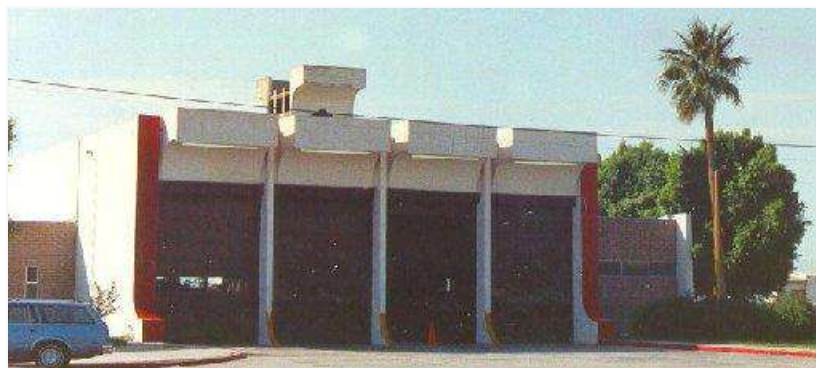
Estación de Bomberos "Lazaro Cardenas"
