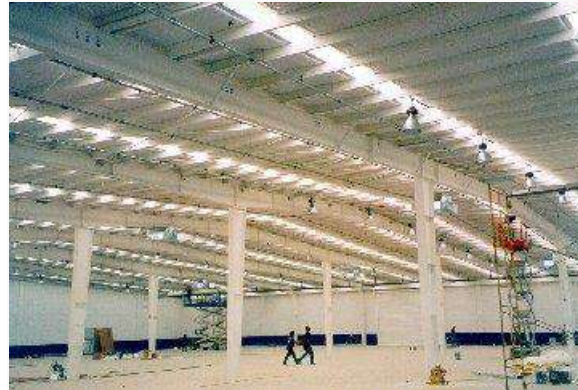
Acondicionamiento de Nave "Rapid Rack"
