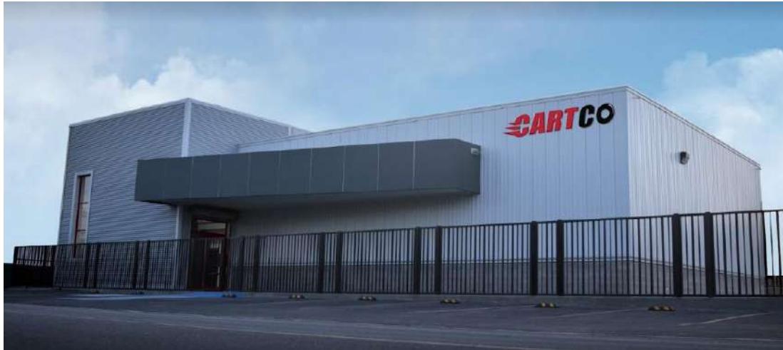
Construcción de Edificio para Oficinas y Almacén Cartco, Calle 5 de Febrero, Mexicali, B.C.
