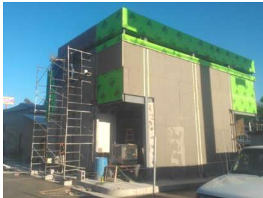
Construcción de Local Stere y 1era Etapa Centro Comercial, Blvd. Benito Juarez Tecate B.C.
