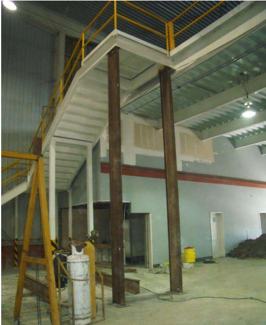
Reforzamiento Estructural Nave Industrial Maran N-19
